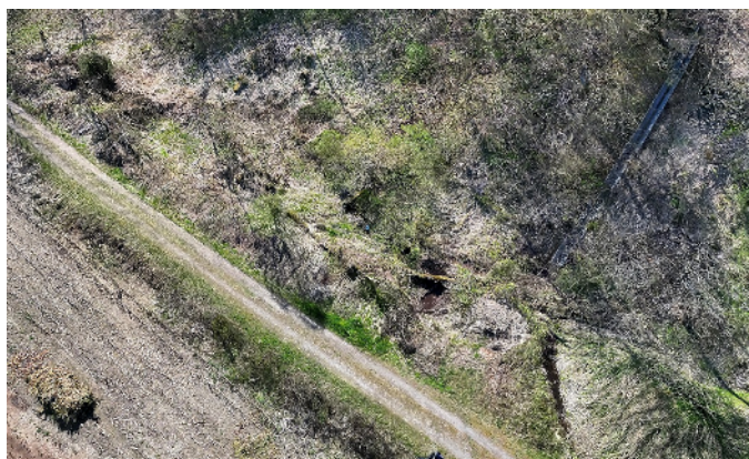
(b) La sorgente e la caditoia/condotta proveniente dal versante montano.
